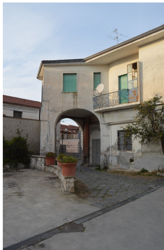
FOTO n.2 – Ingresso dal cortile comune interno.
